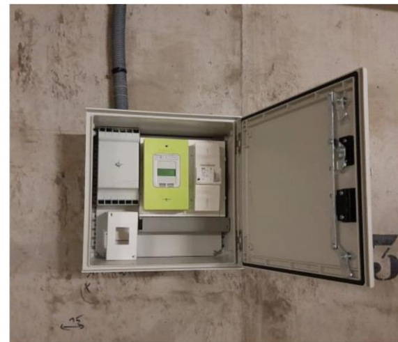
Coffret obligatoire pour un box ouvert ou grillagé, recommandé pour un box fermé
