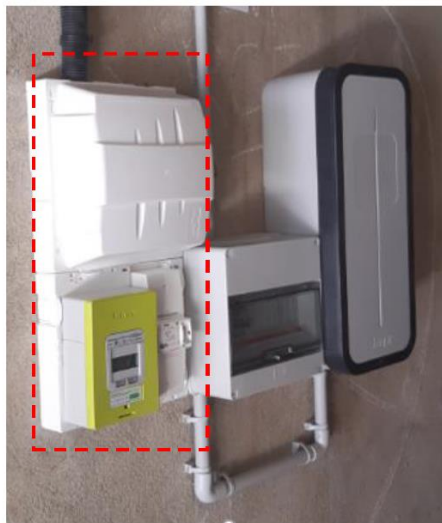
Installation minimale pour un box fermé, et maintenu fermé même en l'absence du véhicule
