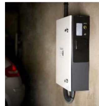
Coffret électrique incluant la borne de recharge,
