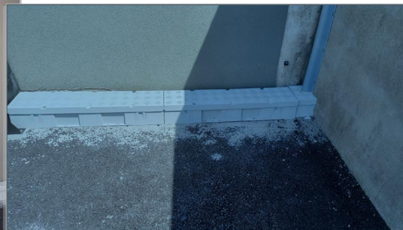
Paire de « totems » posé sur un caniveau sur dalle béton
